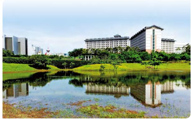
2003年中科落腳於大度山臺中縣、市交界的西屯及大雅地區，開發當時就已將山坡地水土保持的安全納入考量，非常注重園區開發的水土保持規劃與施作，並結合生態工法設計與施工。同時也考量周邊居民及園區進駐人員休憩需要，將滯洪池設計為兼具休閒運動公園及營造濕地生態景緻，目前臺中園區共設置10座大型滯洪池，面積達52公頃，滯洪容量超過法規規定50年洪水頻率的设计標準，大幅提高保護標準來到200年洪水頻率，可提供園區及下游地區嚴密的保護。
