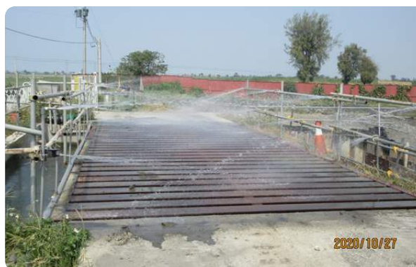
工地出入口設置洗車平台
