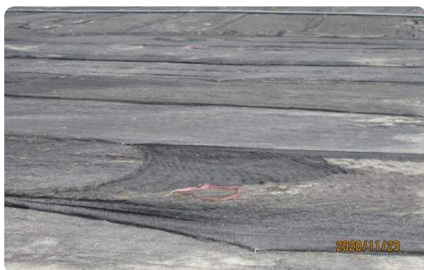
工區內裸露地表以防塵網方式覆蓋，防止揚塵
