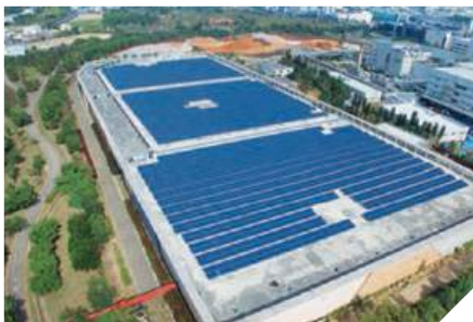
台中園區中區配水池屋頂太陽能電廠鳥瞰圖
